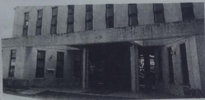
九州ルーテル学院が改修して小学部校舎とする工カド会館。熊本市中心区
