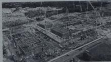
建設工事が進む台湾積体回路製造(TSMC)の新工場予定地(10月、熊本県菊陽町)
